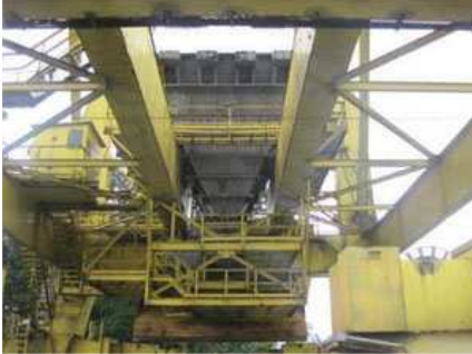
Descarregador de navios da Usiminas
